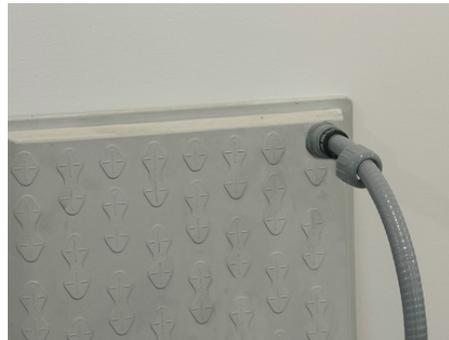
c) Conducto/Conector instalado
