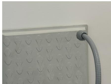
**Nota: El conducto flexible de 3/8" se introduce en el conector aproximadamente 1" (2,54 cm). El conducto debe instalarse correctamente para evitar que el conducto flexible se suelte, exponiendo el cable a la humedad y posibles daños.**
